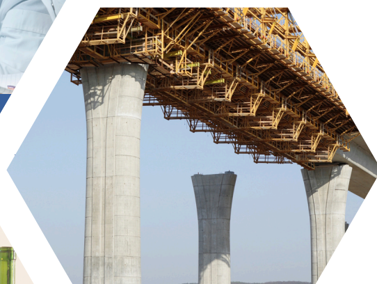
Construction, Shipyards Xây Dựng, Đóng tàu
